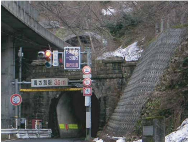
■見どころ：施工は藤田伝三郎。現存する3番目に古い鉄道トンネル。鉄道から道路に転用されたトンネルとしては最長。はじめてダイナマイト、削岩機、コンプレッサー、換気用タービンを使用。三角測量を実施した。
