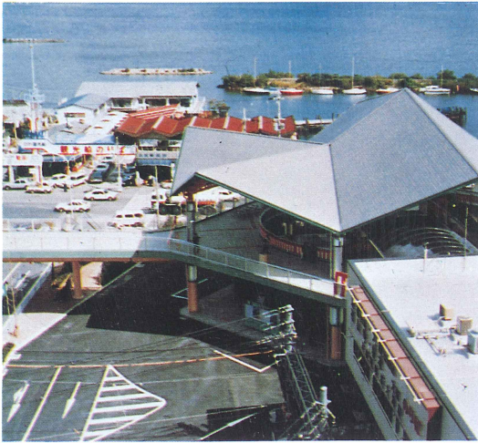
完成した浜大津総合ターミナルペDESTリアンデッキ (デッキ部上屋付立体 ラーメン)
