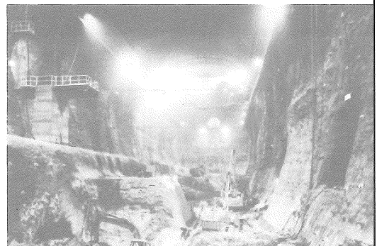
チラタダム 上流面遮水壁型ロックフィルダム(上) 掘削中のチラタ地下発電所(下)
