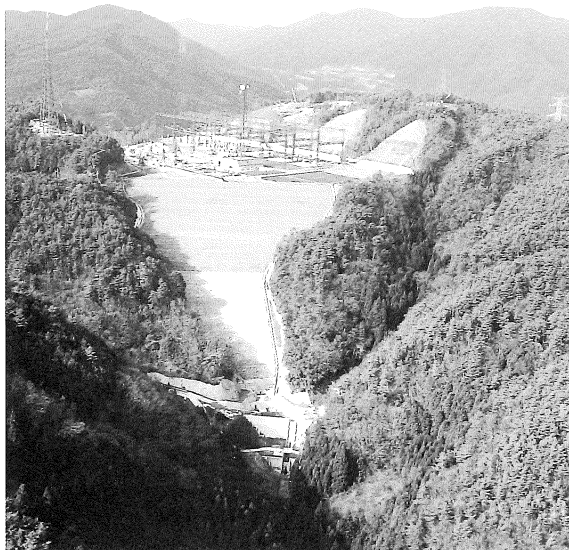
■山岳部における高盛土造成—能勢変電所の建設—
