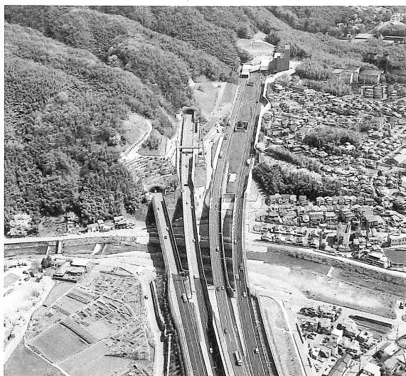
■名神高速道路(改築)天王山トンネル西改良工事
