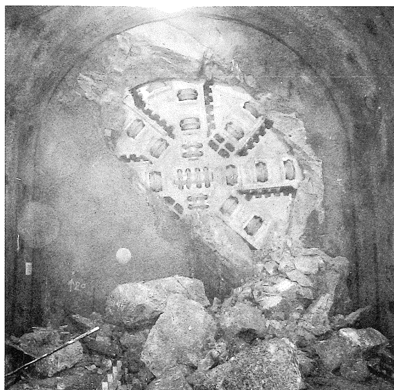
■扁平な大断面長大トンネルにおけるTBM導坑の情報化施工の確立
