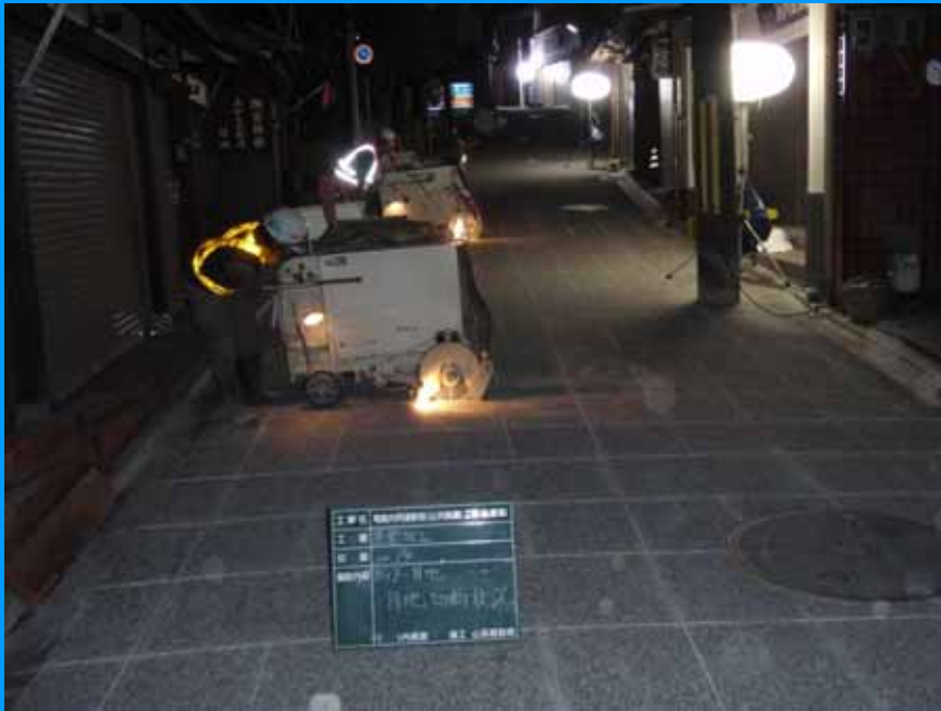
グレービング（目地切り）
