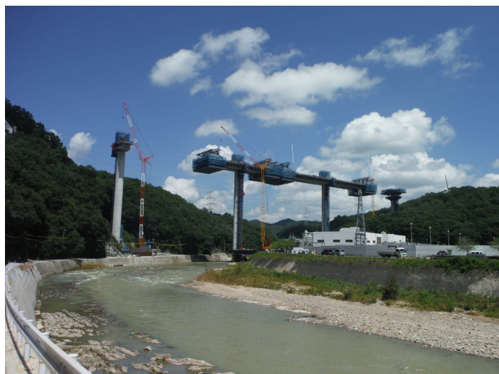
②武庫川橋工事
