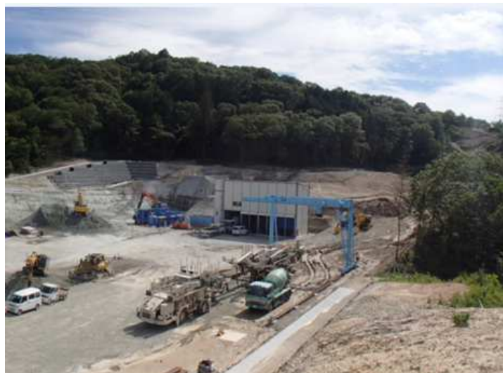
①道場トンネル工事
