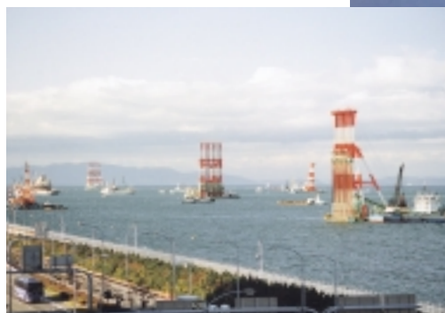
現在の空港島から見た用地造成工事
