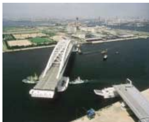
現地据付け状況
