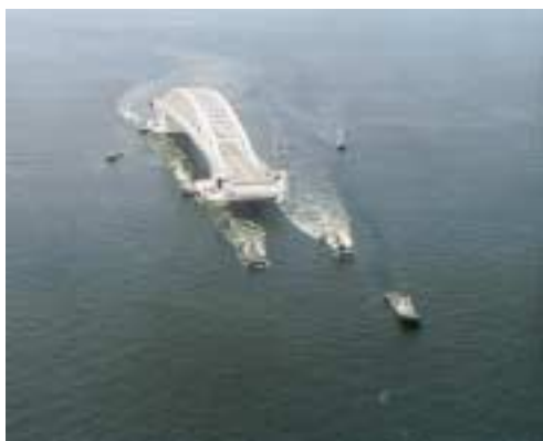
浮体橋曳航中の状況
