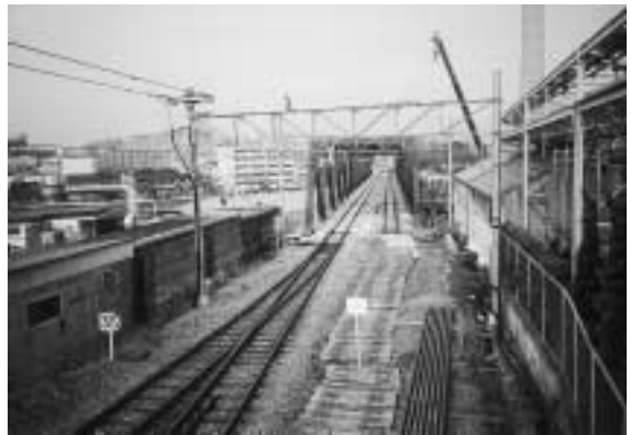
■奈良線鴨川橋梁
