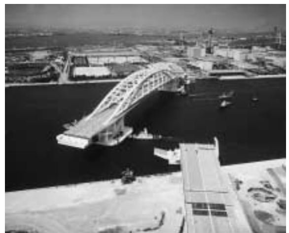
■夢舞大橋の建設
