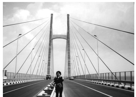
■スエズ運河橋のど真ん中で撮った写真です。 橋の大きさが一目瞭然。
