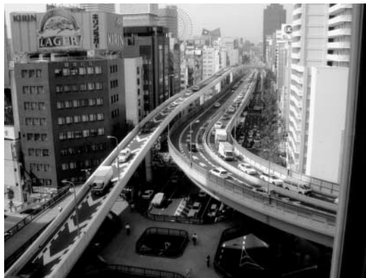
国道423号(新御堂筋線高架)と国道1号の梅新東交差点をオーバーパスする「梅新南ランプ」の完成
