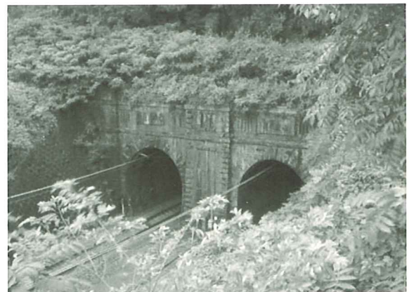
■東山・新逢坂山トンネル
