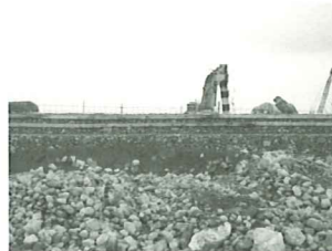
■リド島の建設現場
