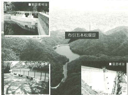
■布引五本松堰堤の堤体補強を中心としたリニューアル工事
