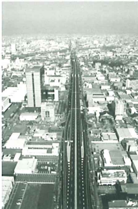
■阪神高速8号京都線城南宮南出路付近から北を望む
