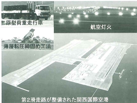
■完成した航空灯火と滑走路整備における技術的取り組み
