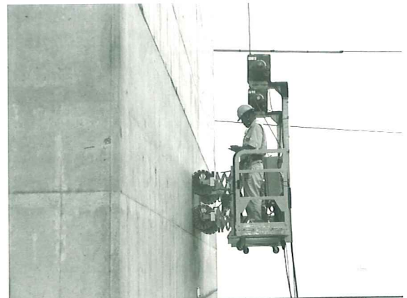
■真空吸着車輪ゴンドラの昇降状況
