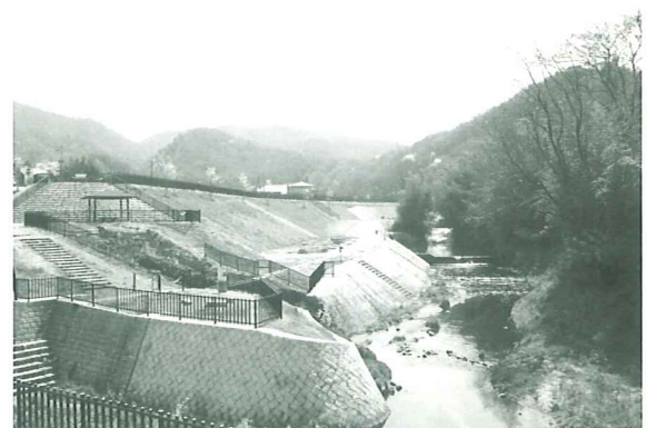
■完成した天野川「水辺プラザ」
