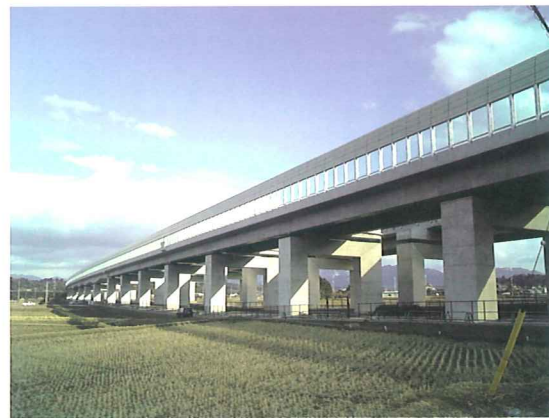
■開放感を持たせた額縁橋脚(池田高架橋)
