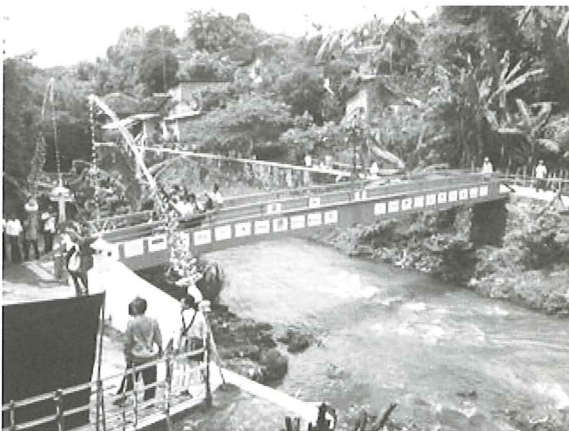
■平成 19 年 2 月、再利用歩道橋の架設が完了。完成式典も盛大に行われた。
