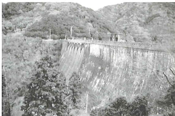
■上田池堰堤（下流面）
