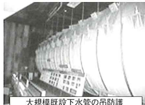
大規模既設下水管の吊防護
