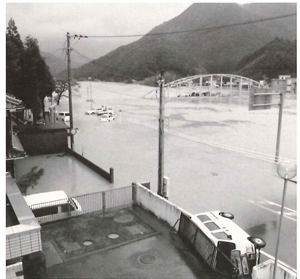
■写真1 相野谷川の越水（三重県紀宝町） （写真提供：国土交通省近畿地方整備局）
