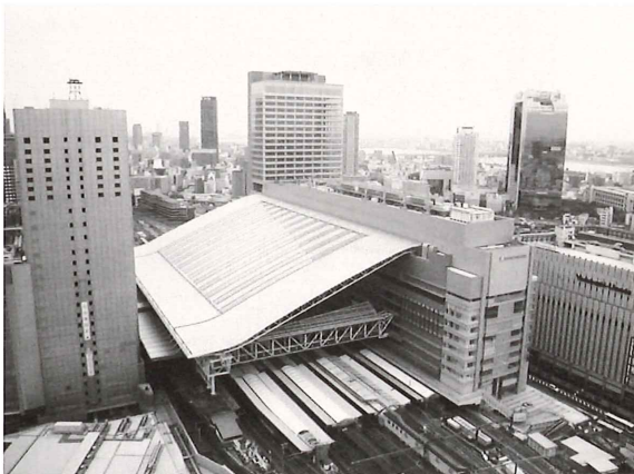
■工事が完了し、グランドオープンを迎えたOSAKA STATION CITY
