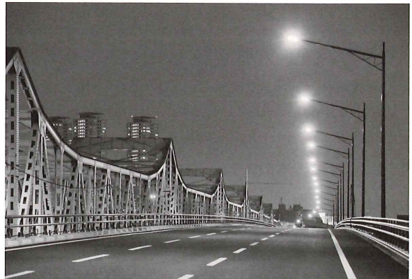
■LED道路照明の設置事例(府道大阪中央環状線・鳥飼大橋)
