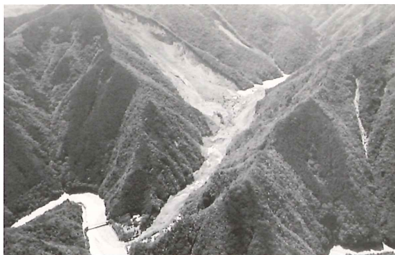
■写真2 大規模河道閉塞(奈良県五條市大塔町赤谷) (写真提供:国土交通省近畿地方整備局)
