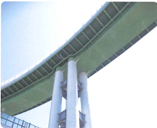
■鋼管集成橋脚 全景
