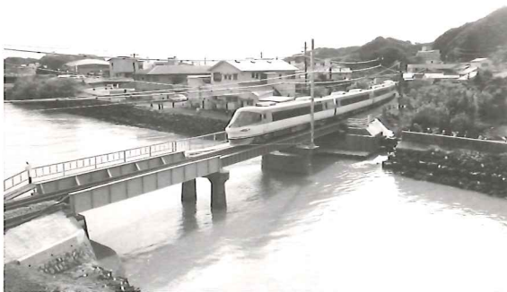
■那智川橋梁復旧工事の完成（運転再開時の様子）
