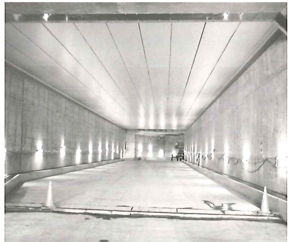
■工事完了後の地下道路ボックス（舗装施工前）
