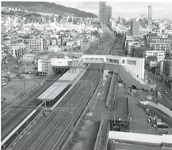
■開業前(工事中)の摩耶新駅
