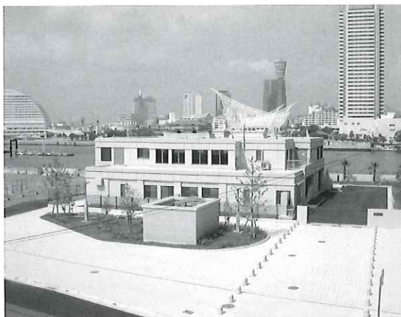
■神戸の景観に配慮した京橋ポンプ場の外観デザイン
