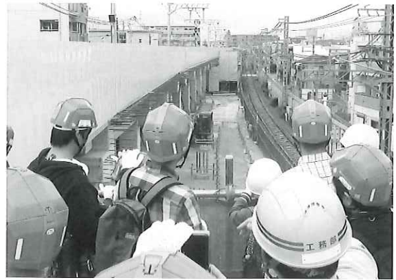
■高架橋の見学
