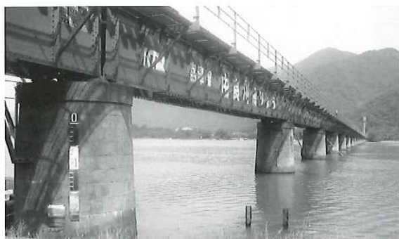
■由良川橋りょう
