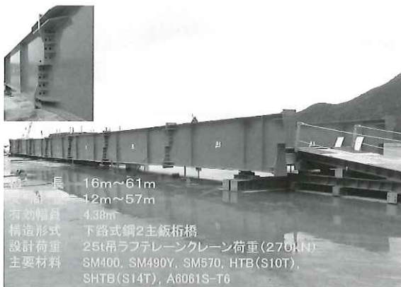
■組み立てた状態の緊急仮設橋と新たに開発した引張ボルト接合を採用した継手
