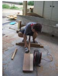
グラインダーで軽量化 写真 -12 パドルの製作
