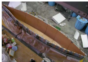
写真 3 高チクソ材外型枠
