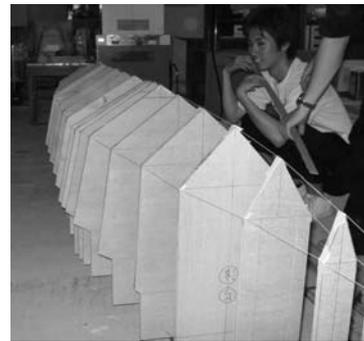
写真-4 型枠配置
