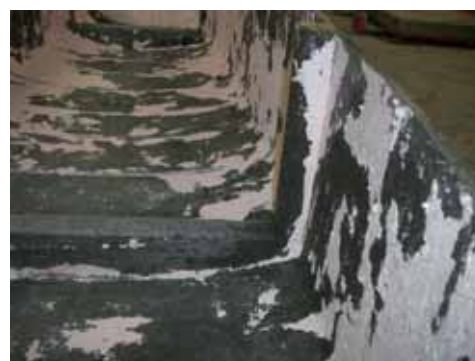
写真-1 カヌー進行直角方向の骨組み
