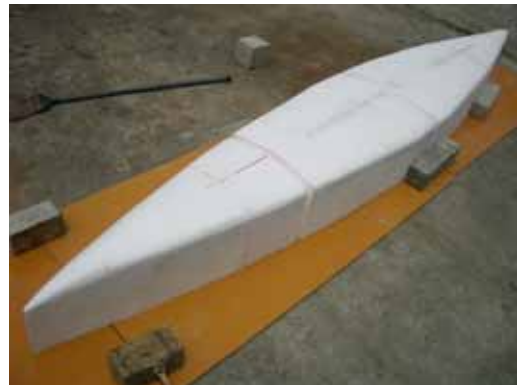
写真-7 型枠成形完成
