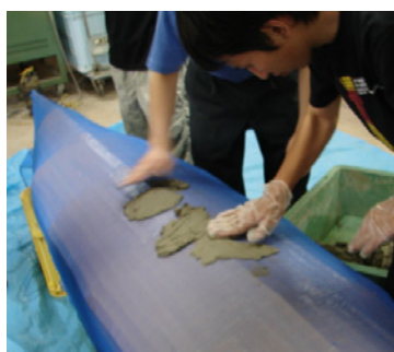
図5 モルタルの打設状況
