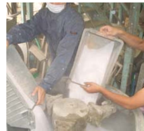
写真-6 軽量骨材の投入状況
