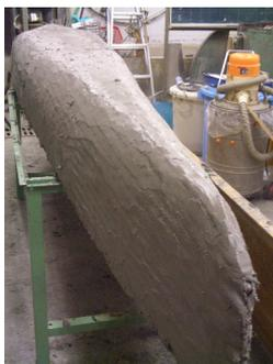
写真-10 超軽量モルタル塗付け完了
