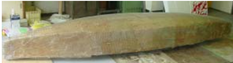
写真-5 型枠上に作製した FRP 型枠 (躯体としては利用せず)
