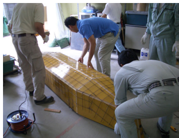
型枠の補強
