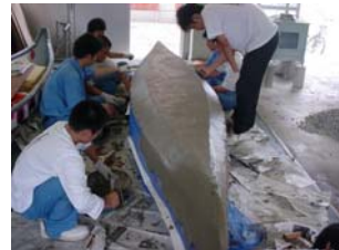
モルタル打設
