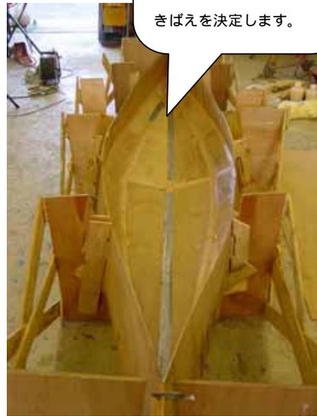
また、船体の歪みはわずかであっても、完成後、水に浮かべ漕いだときに大きな障害となる。ただ目で見ても分からないような、少しのねじれや歪みが、カヌーの直進性を大きく損なわせることになるからである。型枠の精度が重要になるところである。この点をチェックするために船体の中心線方向を基準として水平方向また斜め方向に糸を張り、型枠固定時に微調整を施した。更にモルタルの厚みの不均一による重心の偏りにも注意が必要である。バランスの取れていないカヌーは、漕いだときに直進せず、船首が左右に振れてしまう癖がでて、コントロールが困難になるためである。この点においても厚さの均一化を図るために細心の注意を払って施工した。
