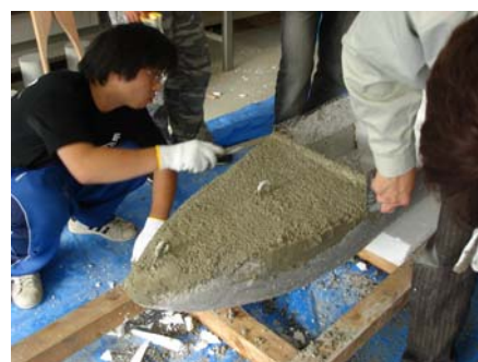
写真-8 残した型枠を埋め残し
