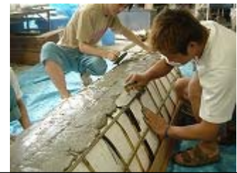
セメントモルタルの塗り込み
